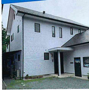
外壁塗装工事
