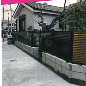
フェンス工事
