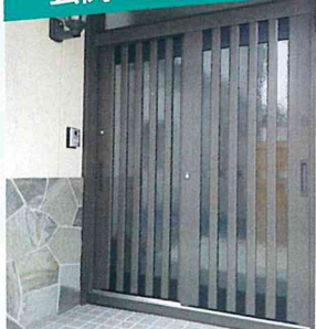
玄関・ドア工事
