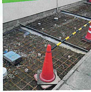
下水・土間工事
